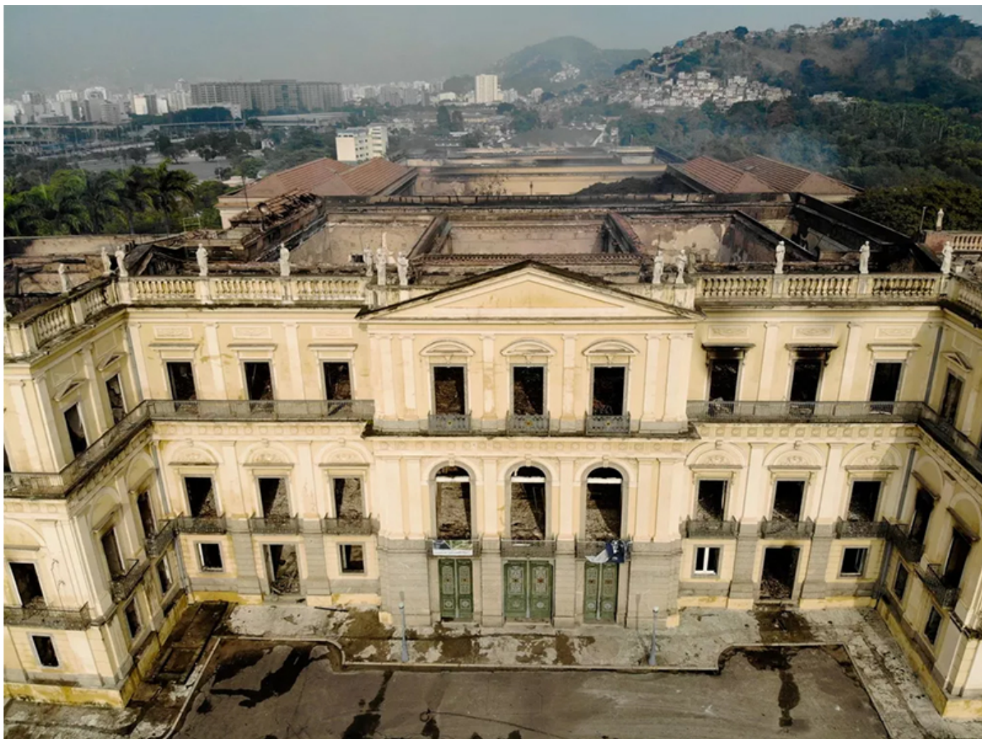
Figura 5. Vista aérea del Museo Nacional, en Río de Janeiro, destruido tras el incendio
